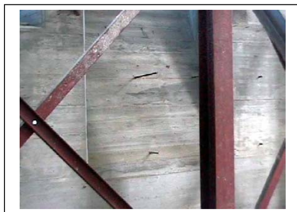
Fig 7 Particolare di un lato del basamento.
